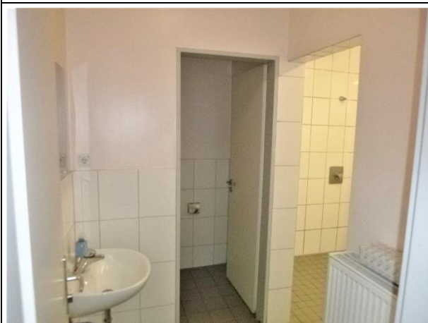
Bild 25: Nassräume, Wandfliesen in Dünnbettmörtel, neuartig (Kein Asbestverdacht)
