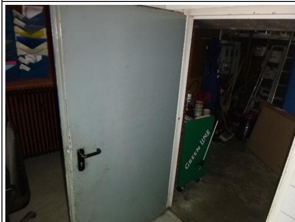
Bild 21: Tür zum Heizraum FH-Tür, unterstellt asbesthaltig und KMF-haltig.
