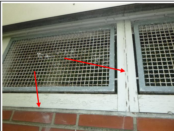
Bild 26: Fassade, Fugen aus Silikon, kein Gefahrstoffverdacht.
