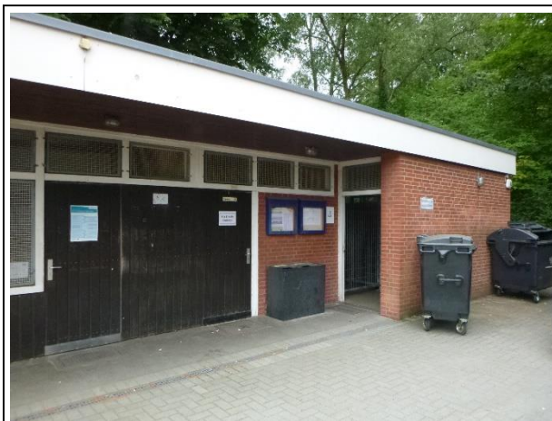
Bilder 17 und 18: Gebäude Umkleideräume in Massivbauweise mit Sichtmauerwerk. Flachdach, Holzkonstruktion mit Mineralwolldämmung (unterstellt KMF, K1B-Material) raumseitig mit Gipskartonverkleidung/Holzverkleidung. Flachdach wetterbedingt nicht geöffnet (Regen) Fußboden: Fliesen in Dickbettmörtel, kein Asbestverdacht.
