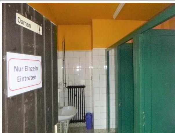
Bild 22: Nassräume. Wandfliesen in Dickbettmörtel: kein Asbestverdacht. Wandputz und Deckenspachtelung (MP5 – kein Asbest), Fußboden: Fliesen in Mörtelbett. Verbundestrich.
