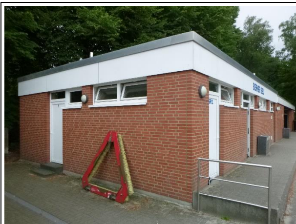
Bild 23: Anbau, zusätzliche Umkleideräume mit WC/Dusche, Wände/Decken Verputzt, Bodenfliesen (neuartig) Kein Gefahrstoffverdacht)
